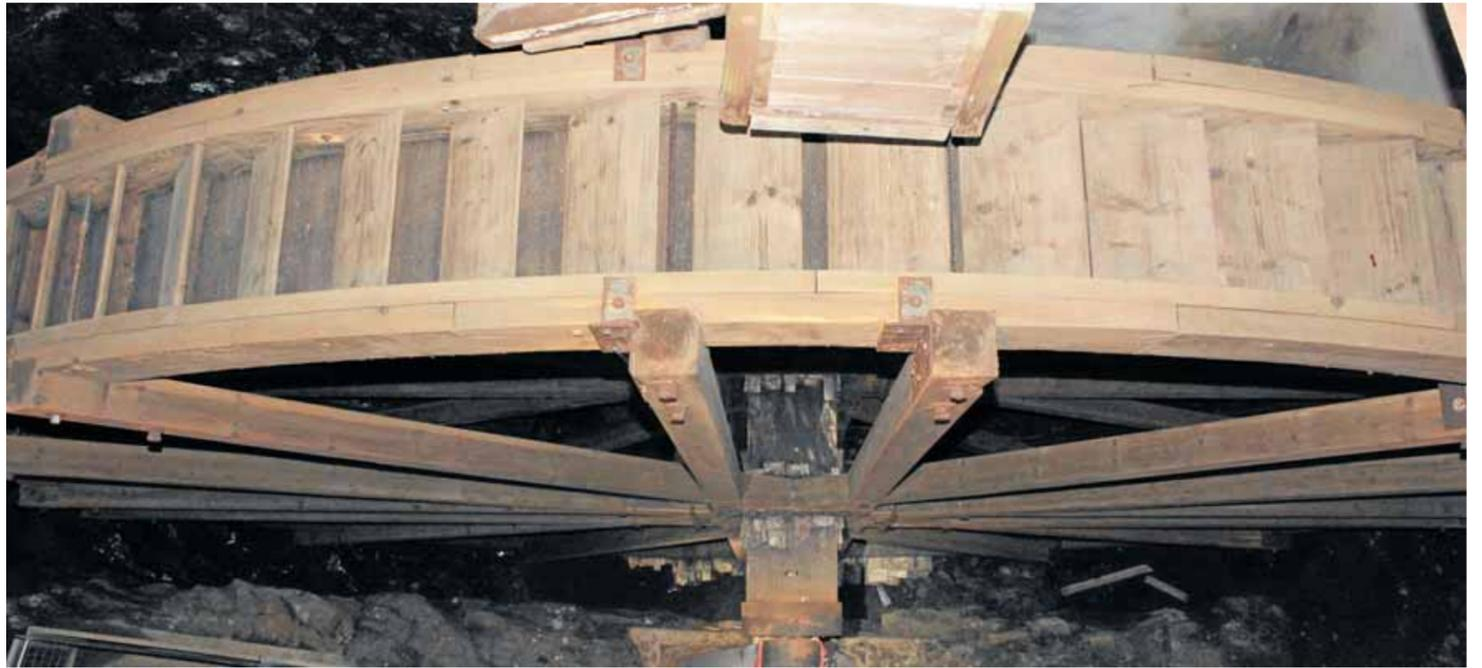
Das mächtige Kunstrad aus Fichtenholz von oben in der Grube Samson: In der Achse steckte der Metallstift, der gebrochen ist. Die gesamte Konstruktion muss erneuert werden.
